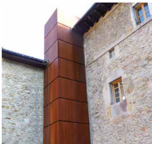
Rehabilitación por calle CON ESTRUCTURA METÁLICA, adaptado al espacio e integrado en la arquitectura del edificio.
