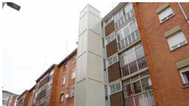
Rehabilitación por fachada de calle con acceso directo a viviendas con uso de llavines. Estructura en chapa.
