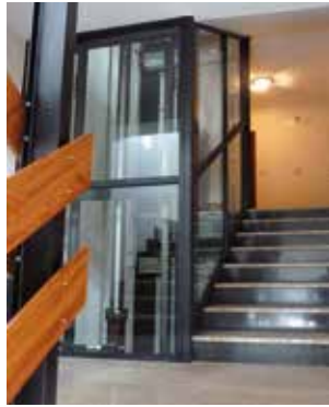
Rehabilitación con demolición de un tramo de escalera, creando un nuevo acceso de escalera.
