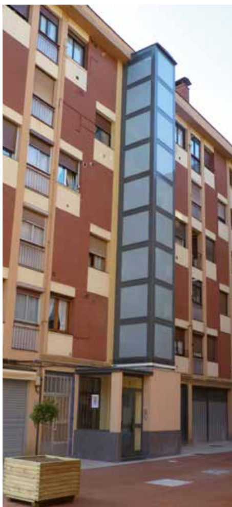
Rehabilitación por calle CON ESTRUCTURA AUTOPORTANTE, esto es, independiente del edificio y sin ejercer cargas sobre él. Solución sencilla y económica, que elimina la necesidad de obras. Terminaciones: chapa, melamina o cristal. Varios colores disponibles.
