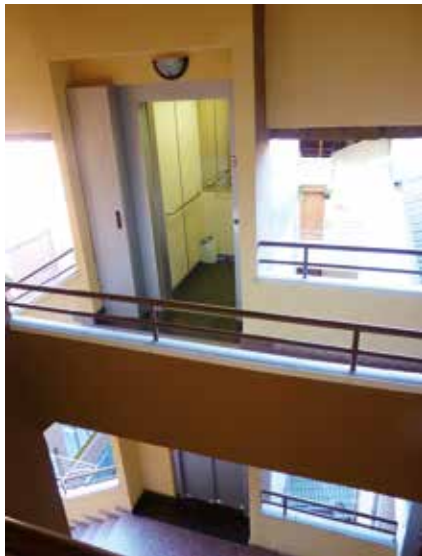
Rehabilitación por patio con estructura autoportante con disponibilidad en varios materiales y colores.
