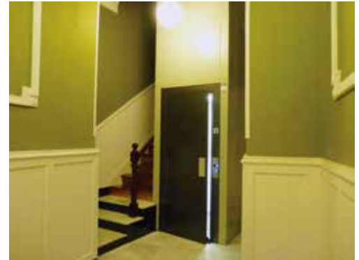
Por hueco de escalera con demolición de parte de la escalera de madera.
