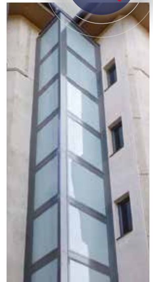
Rehabilitación por patio con estructura autoportante con disponibilidad en varios materiales y colores.
