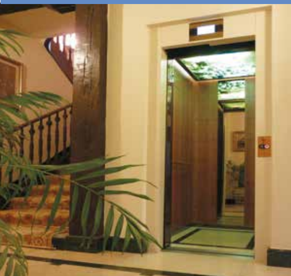
Sustitución parcial. Cabina y puertas.
